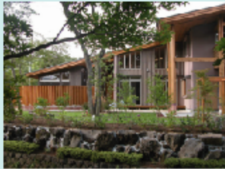
雨の多い伊豆に対応した、大屋根と軒の深い佇まいがデザインの特徴となっている。主材は天城山の杉材。
